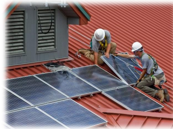
Colocación de paneles solares.
